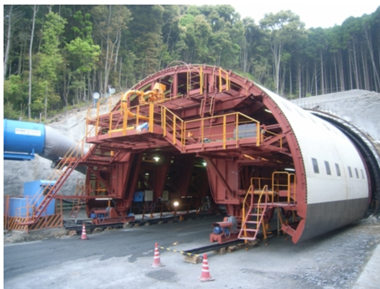
古江トンネル南新設工事に用いたFRP製セントル
