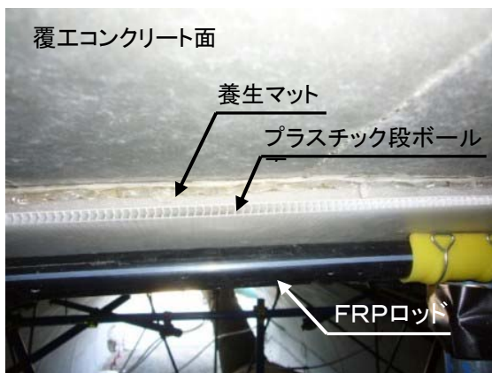
写真3 養生マット支持構造
