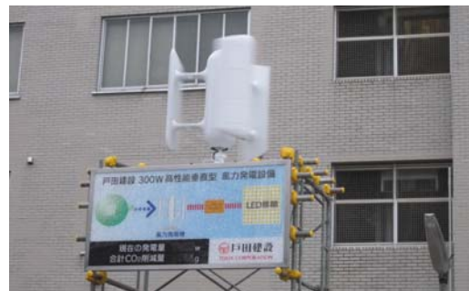
写真-2 表示器と風力発電システム
