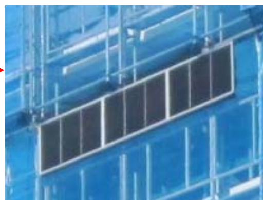
写真-1 (左上) ユニット足場に設置された 太陽光発電パネル
