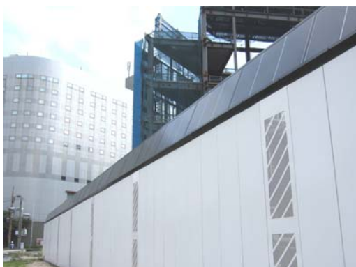
写真-1 (左上) ユニット足場に設置された 太陽光発電パネル
