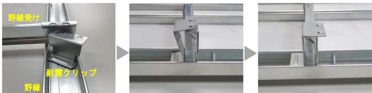
①耐震クリップを斜めにして野縁の間に挿入
