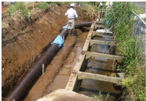
写真5. カワモズクに配慮した排水工事
