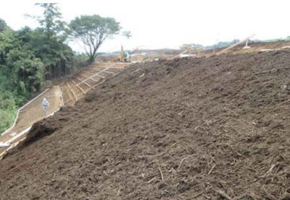
写真6. 伐採した樹木の木チップを斜面土として再利用
