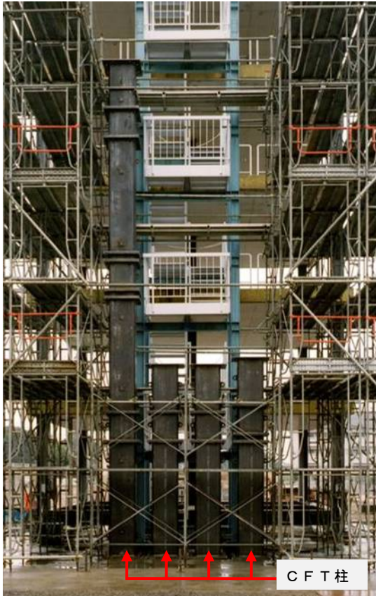
施工実験全景
