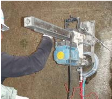
写真-2 コア削孔 (φ42mm)
