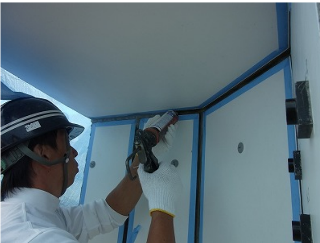
写真-5 目地材のコーキング
