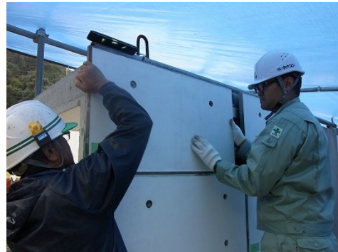
埋設型枠組立状況
