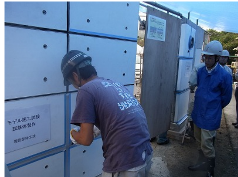
目地材充填状況
