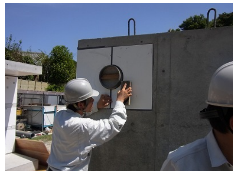
シート固定状況
