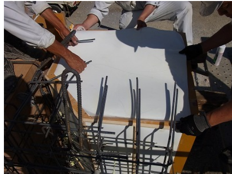
シート固定状況
