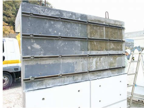
固定用治具取付状況
