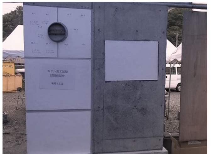
写真-8 モデル施工試験（後貼り工法）施工完了
