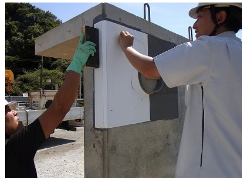
シート貼り状況
