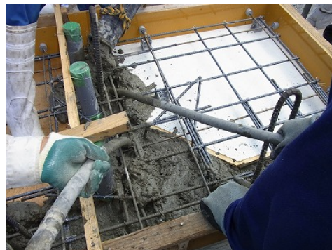
コンクリート打設状況
