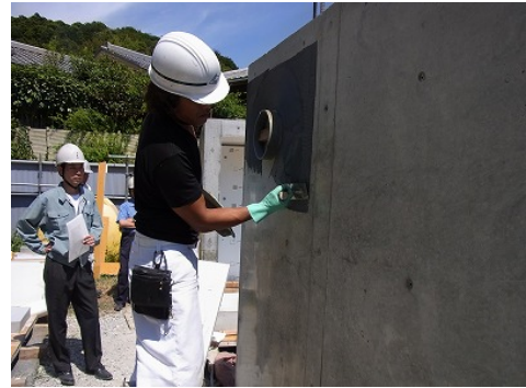
接着剤塗布状況
