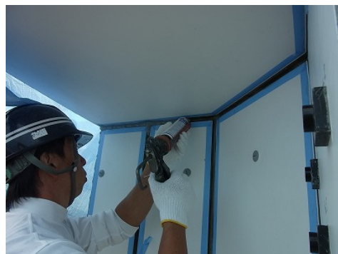
目地材充填状況
