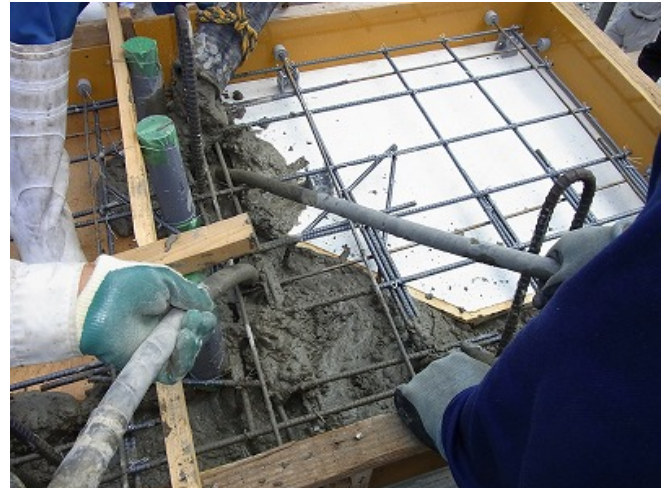
写真-4 コンクリート打設
