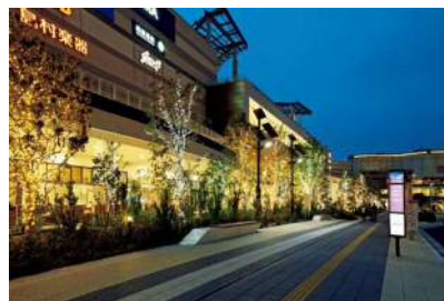
写真一 イオンモール幕張新都心新築工事
