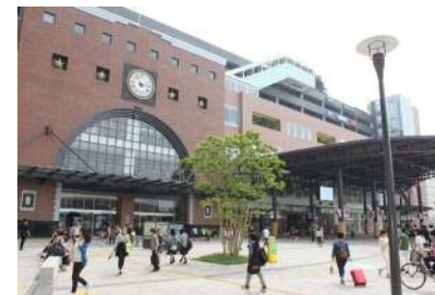
写真二 大分駅前南口歩道整備工事
