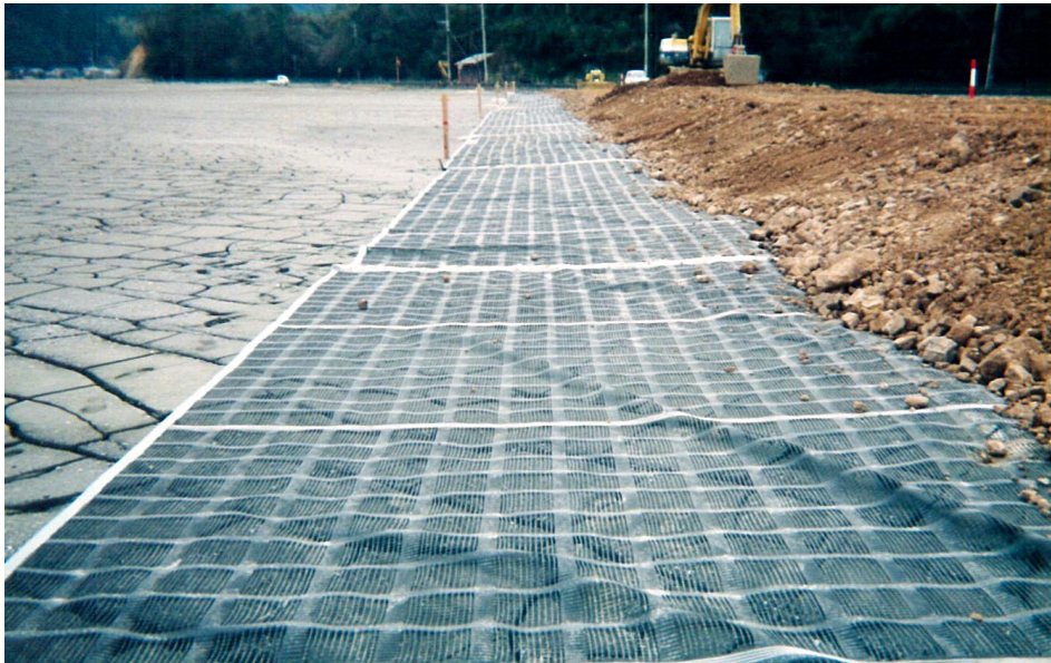
写真-2 施工例（軟弱地盤処理工）
