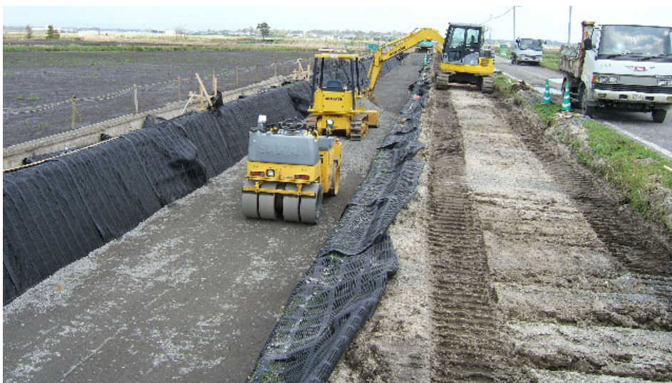
写真-1 施工例（地盤補強工法）
