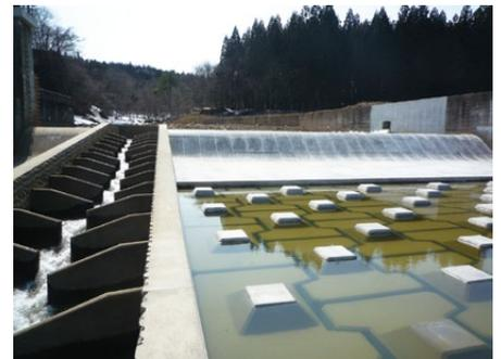
写真-8 頭首工磨耗対策
