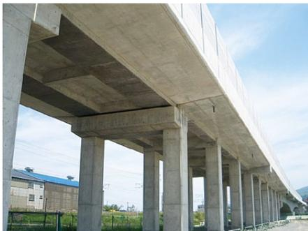
写真-6 桁下塩害対策
