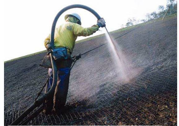
写真－1 吹付け状況
