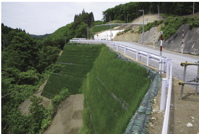
写真-3 補強土壁工法
