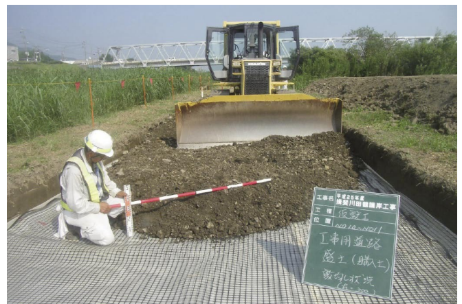
写真-6 敷設材工法盛土材敷均し
