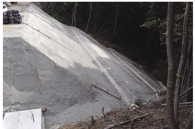
写真-4 補強盛土工法
