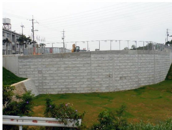
（長田団地建替第1期工事(造成)）
