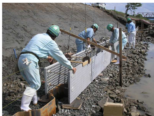
④ 法留基礎ユニット化施工例
