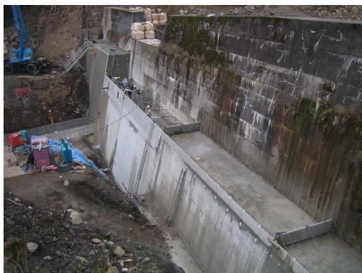
① 砂防えん堤腹付け
