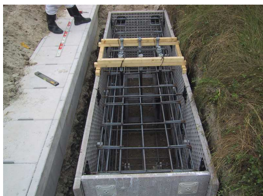
③ 標識基礎ユニット化施工例
