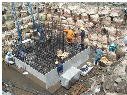
⑤ 橋脚基礎
