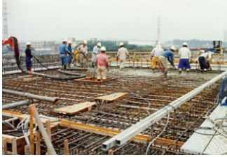
コンクリート打設
