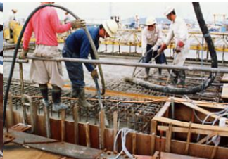
コンクリート打設
