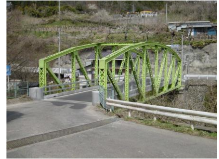
単独道路維持修繕事業（小袖橋）
