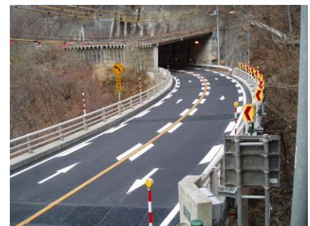
三丁橋橋梁補修工事
