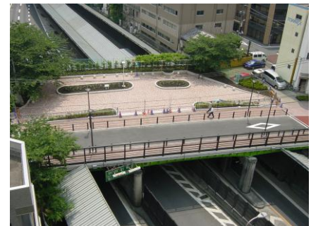
橋梁耐震補強整備工事及び塗装工事 （新富橋）
