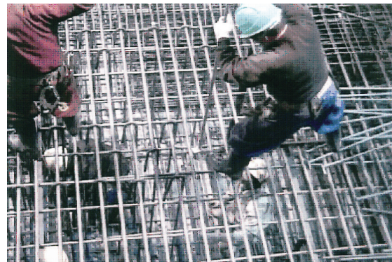
b) 底版の施工
