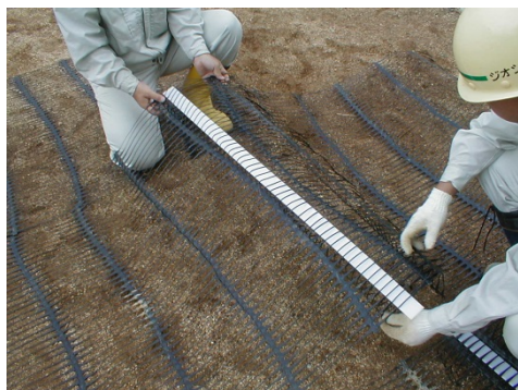
補強材同士の接続
