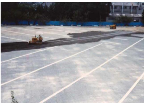
5)土砂まきだし状況
