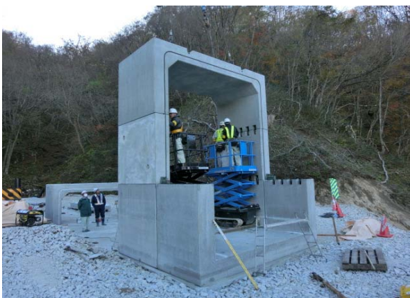
写真-4 頂版の設置
