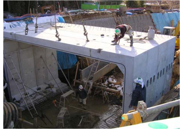
3分割ボックスカルバート B8000×H4210 長野県 千曲建設事務所
