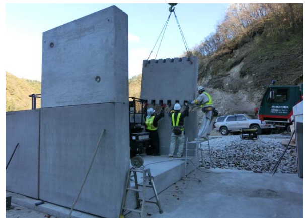
写真-3 側版の設置
