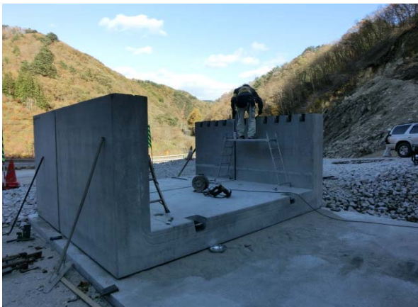
写真-2 底版の設置
