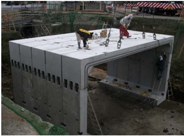
3分割ボックスカルバート B7800×H3800 群馬県 伊勢崎土木事務所
