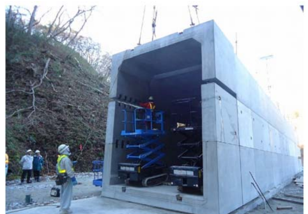
写真-5 施工完了
