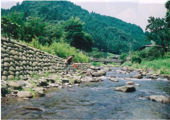
東京都：養沢川護岸
