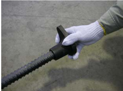
「プレートフック」取り付け
