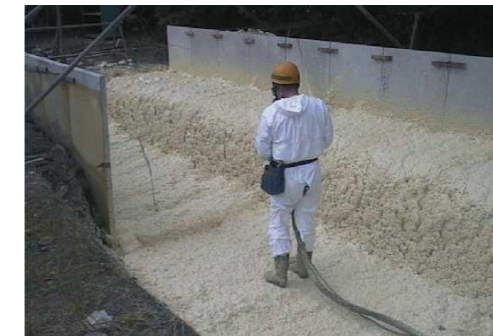
写真—1 ウレタンLH吹付け施工
