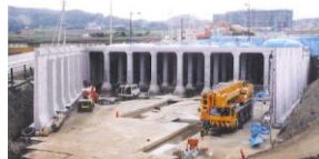
写真-2 組み立て状況
