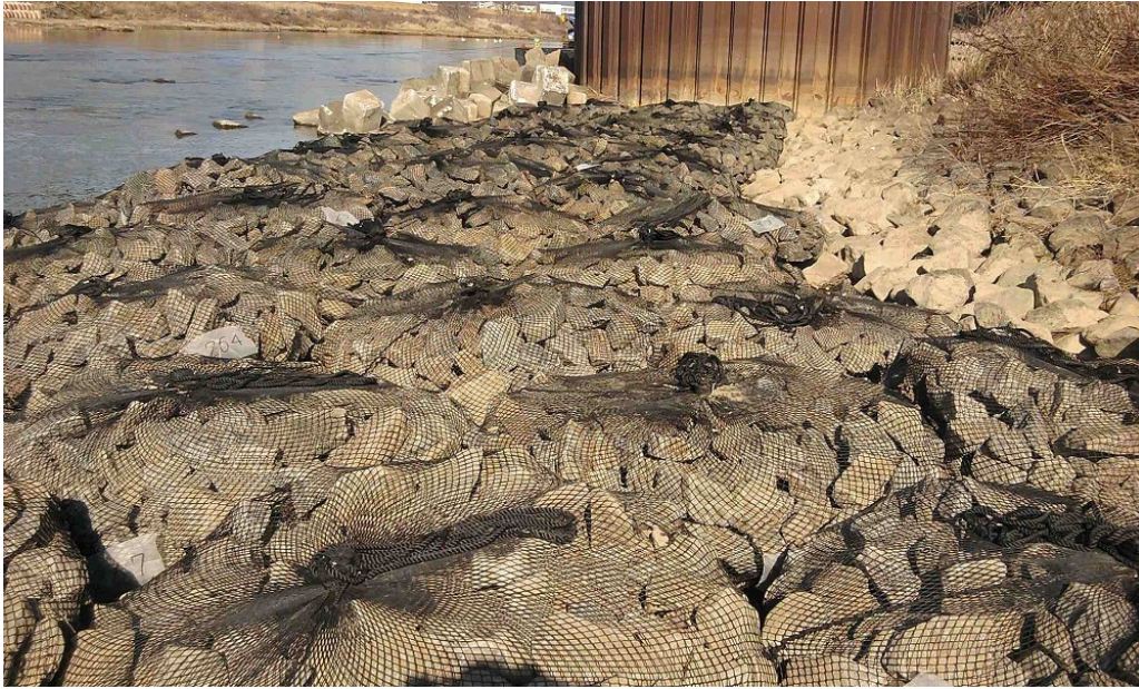
写真-1 スーパーE-ユニット施工例
