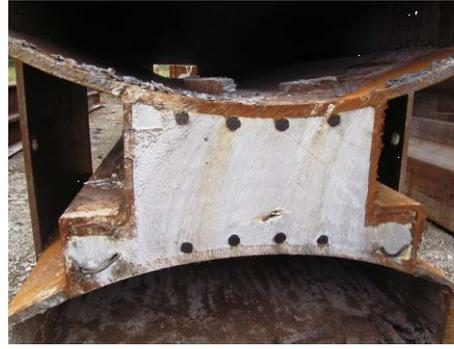
モルタル充填継手断面
