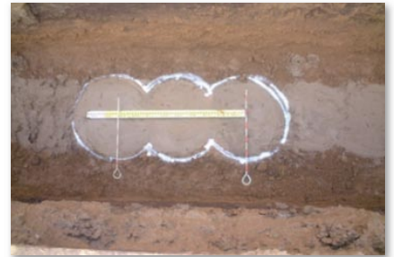
柱列式による壁体形状
