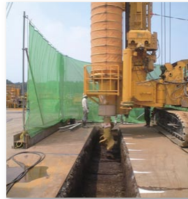
施工状況(柱列式)
