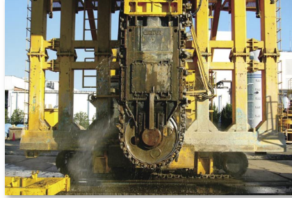
施工状況(等厚式)
