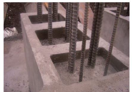
⑥生コンクリート下越し
