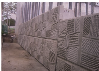
⑧2 段目据付
