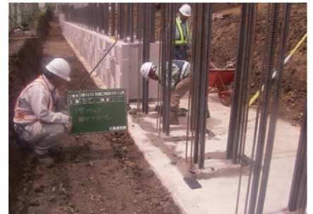
③調整モルタル敷設
