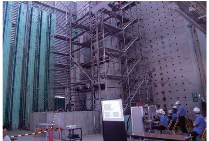
実大載荷試験状況
