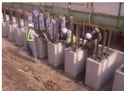
⑤生コンクリート打設状況
