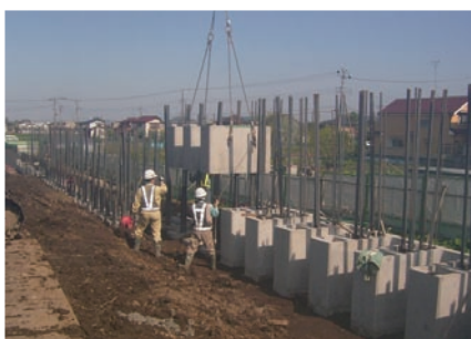
⑦2 段目据付状況
