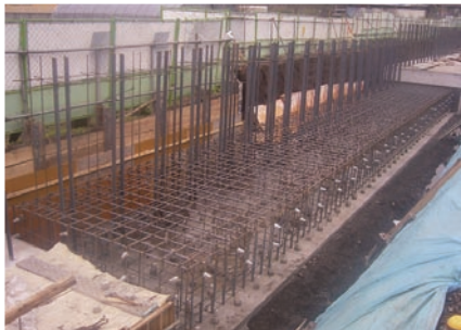
①基礎フーチング鉄筋組立
