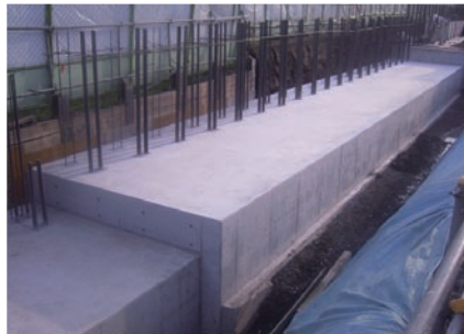
②基礎フーチング
