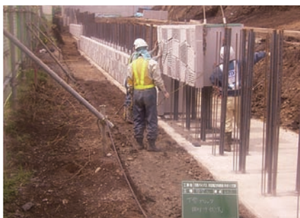
④1 段目据付状況
