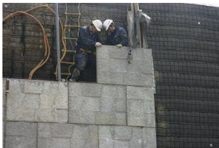
壁面材の撤去・再設置
