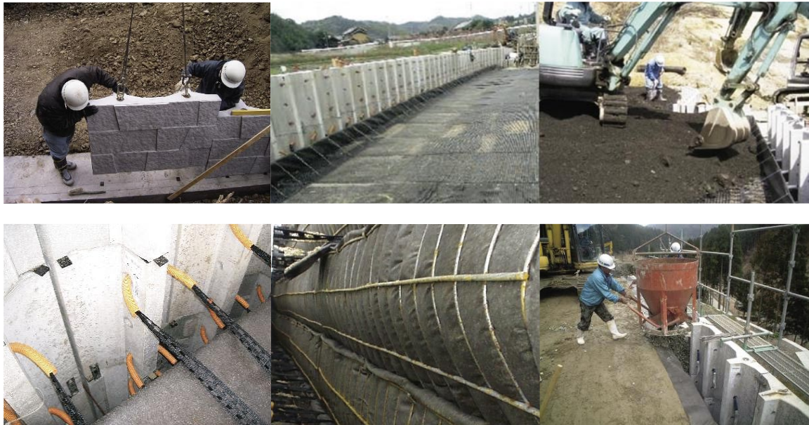
アダムウォールの施工
