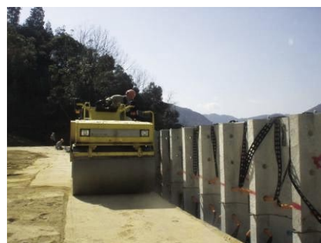
重機による壁面近傍の締固め状況
