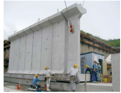
(3) 中間部材据付け
