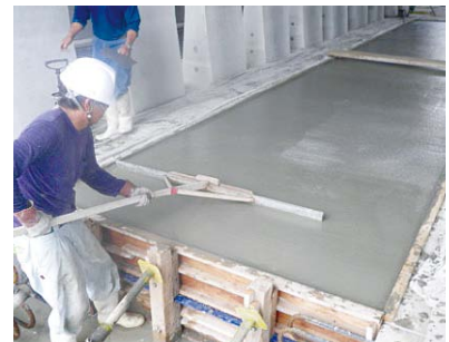
(6) 底版場所打ち部打設
