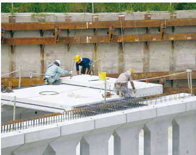
(4) 頂版スラブ据付け
