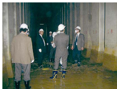
(5) 施設内の目視確認状況
