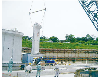
(2) 端部部材据付け
