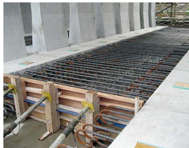
(5) 底版場所打ち部配筋
