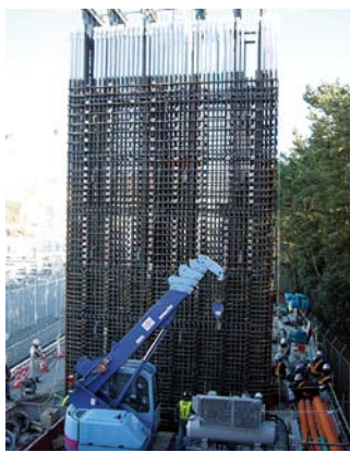
鉄筋組立てユニットの揚重状況
