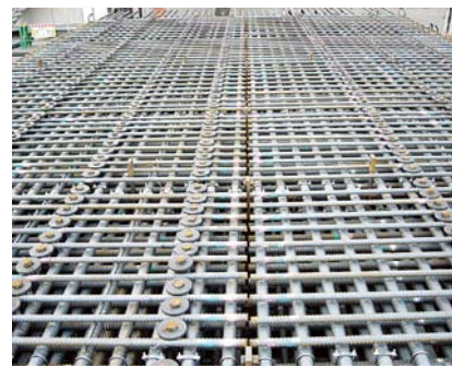
現場サイトの鉄筋組立てユニット(拡大)
