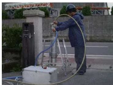
写真-2 取付管ライニング 押込み工法機材
