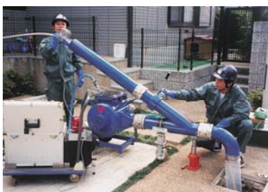
写真-1 取付管ライニング 反転工法機材
