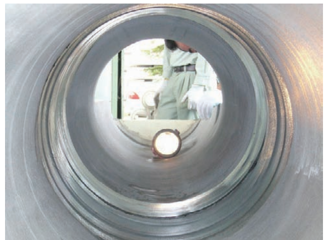
写真-2 施工後の管内状況
