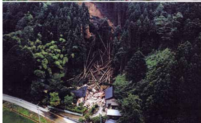
Fig. 18 出雲崎町中山地区の崩壊。1名が犠牲になった。(Fig 17の )。
