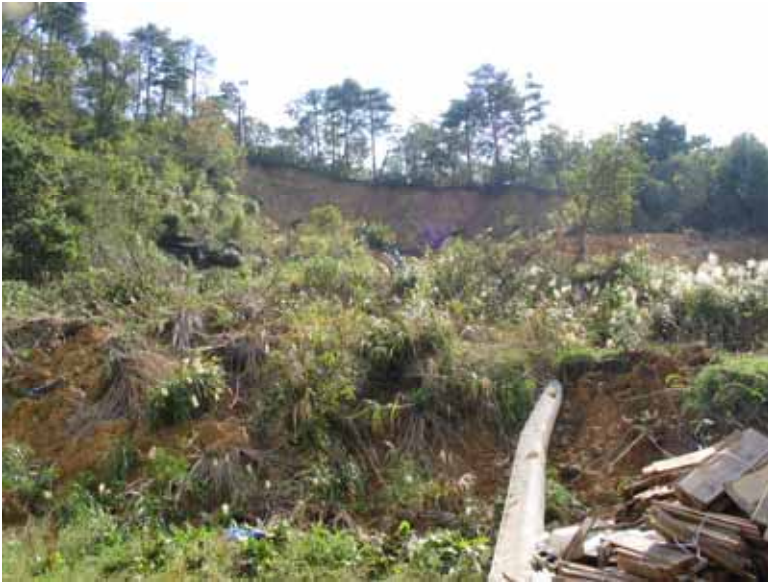
Fig. 15 見附町清掃センター裏の地すべり。
