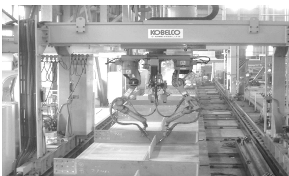
ロボットによる自動溶接
