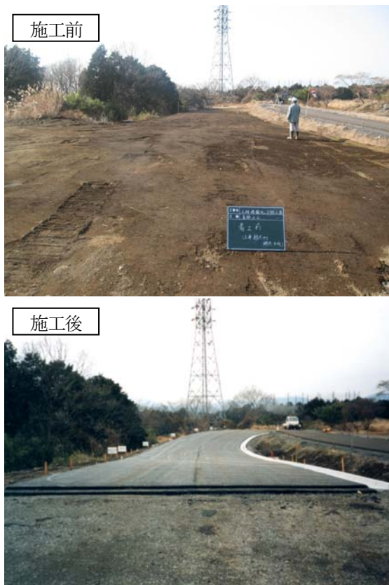
図-13 実証実験現場写真
