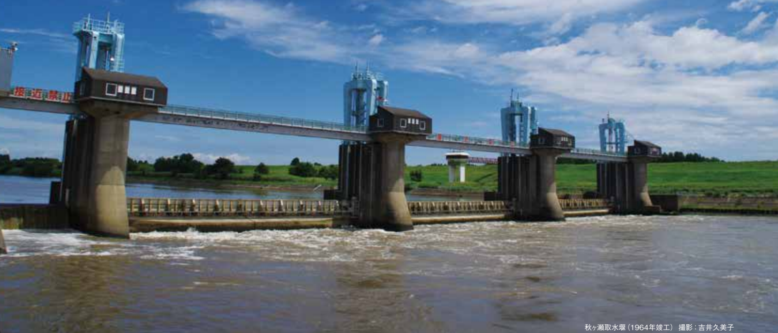
秋ヶ瀬取水堰 (1964年竣工) 撮影: 吉井久美子
