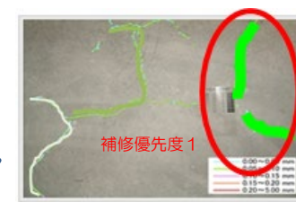
【画像・映像情報の活用目的】 損傷部及び補修優先度の 評価・判定結果を表示
