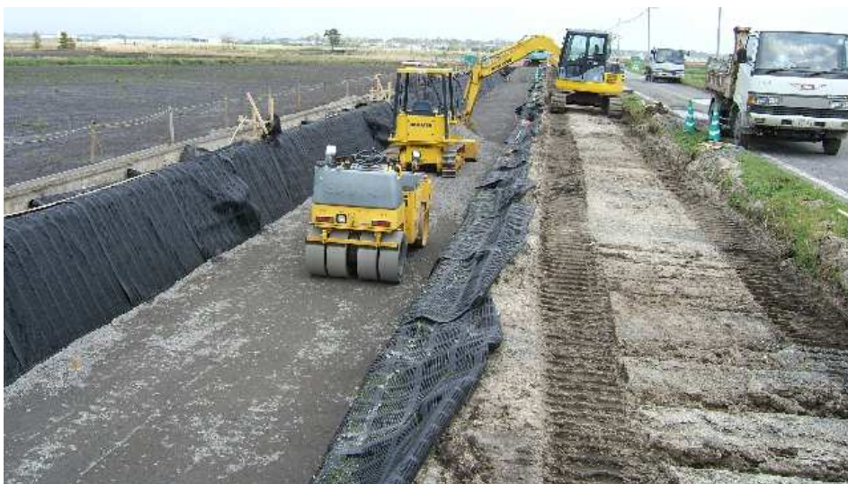
写真-1 施工例（地盤補強工法）
