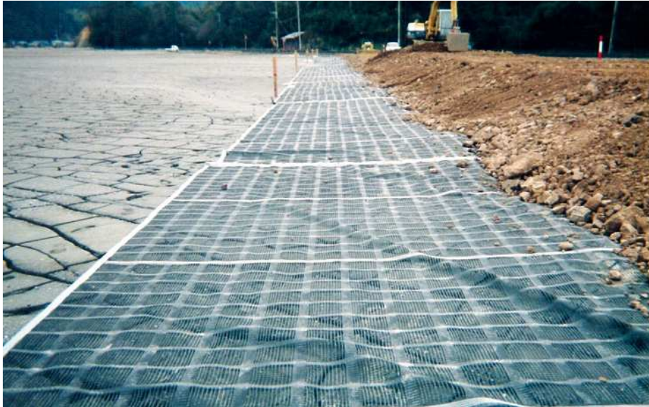
写真-2 施工例（軟弱地盤処理工）
