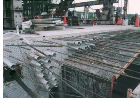
写真-1 打継目の施工状況
