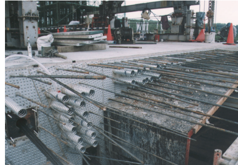
写真-1 打継目の施工状況
