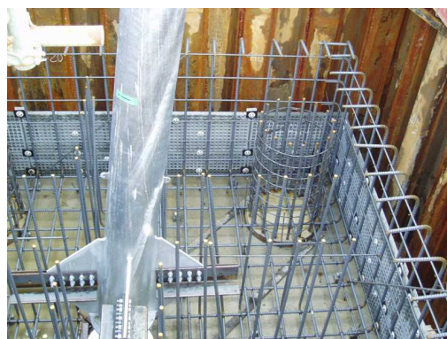
⑥ 送電線鉄塔基礎
