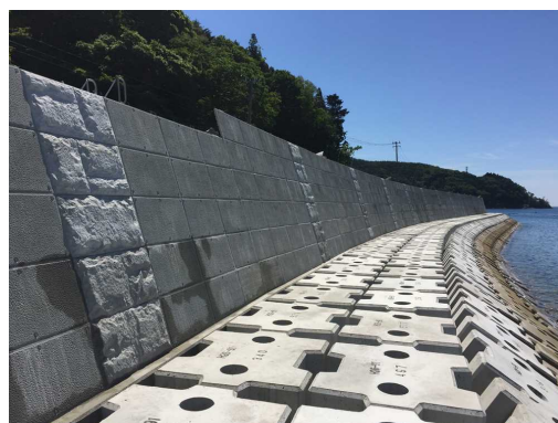
⑧ 海岸防潮堤
