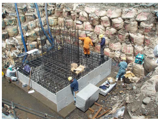
⑤ 橋脚基礎
