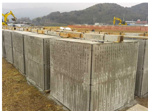
⑦ 河川護床工(根固めブロック工)
