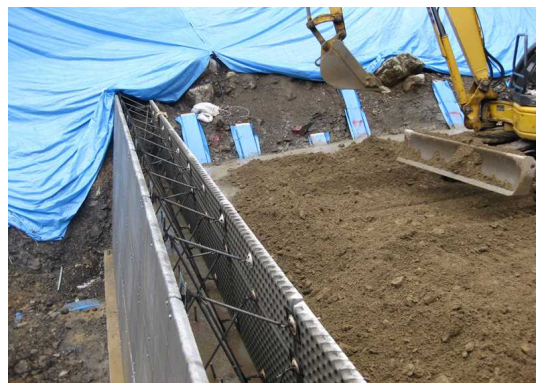
② INSEM 工法かべーコンクリート
