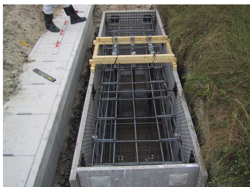
③ 標識基礎ユニット化施工例
