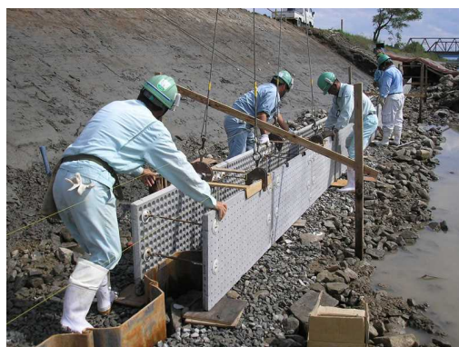
④ 法留基礎ユニット化施工例
