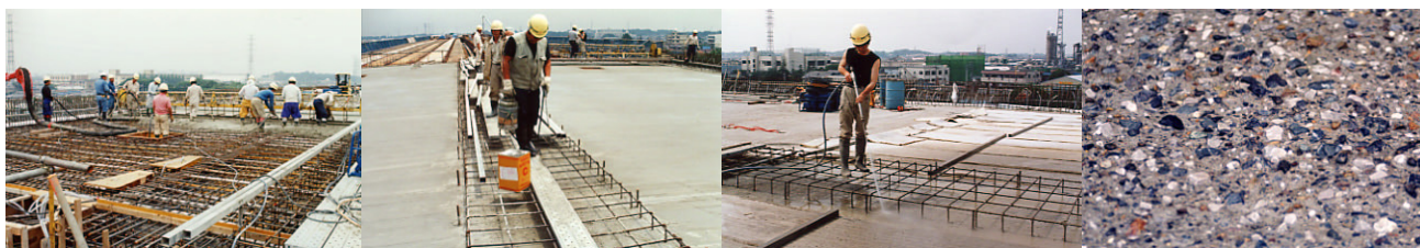
コンクリート打設
