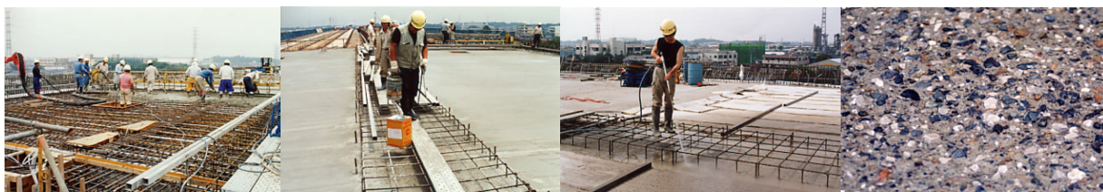
コンクリート打設
