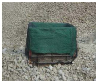
①袋材の設置
