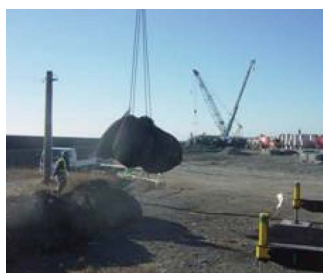
⑤吊り上げ
