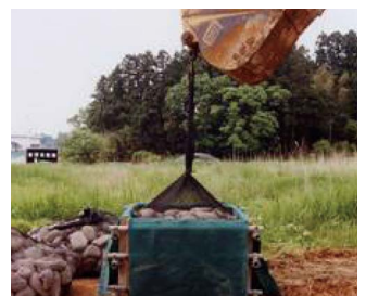
④吊り上げ
