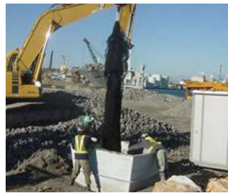
②袋材を型枠へ装着
