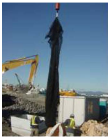
①袋材の吊り上げ
