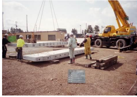
STEP-1 HSLスラブの搬入
