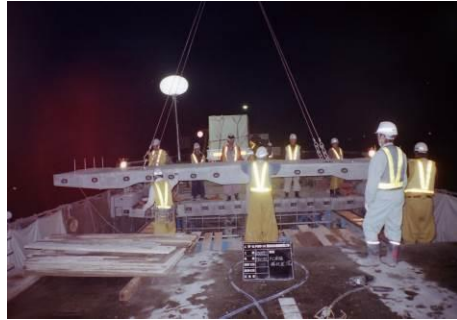
STEP-3 HSLスラブの架設
