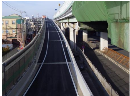
コンクリート床版大規模修繕工事 （玉出入路ランプ橋）
