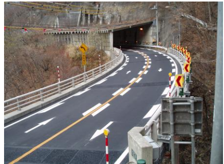
三丁橋橋梁補修工事
