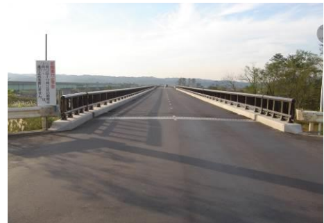
STEP-6 工事完了
