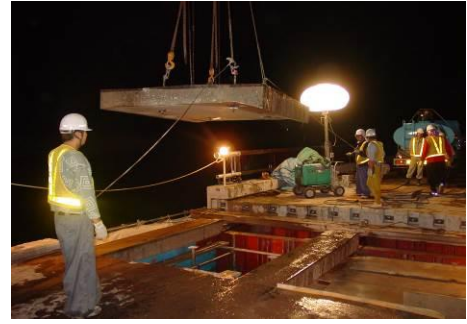
STEP-2 既設床版の撤去
