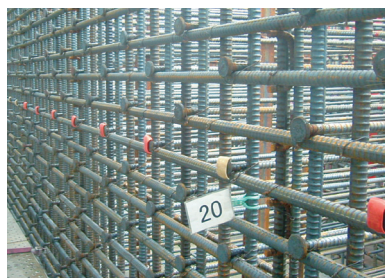
図-11 シールド発進立坑側壁(TH25)
