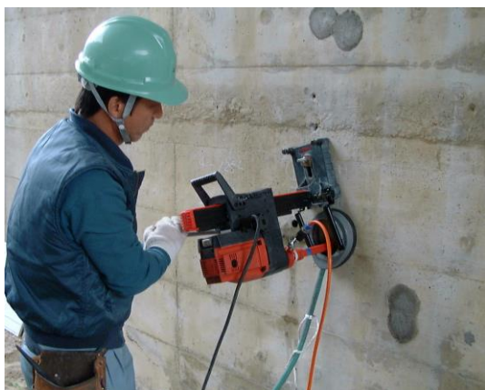
写真1 小径コアの採取状況
